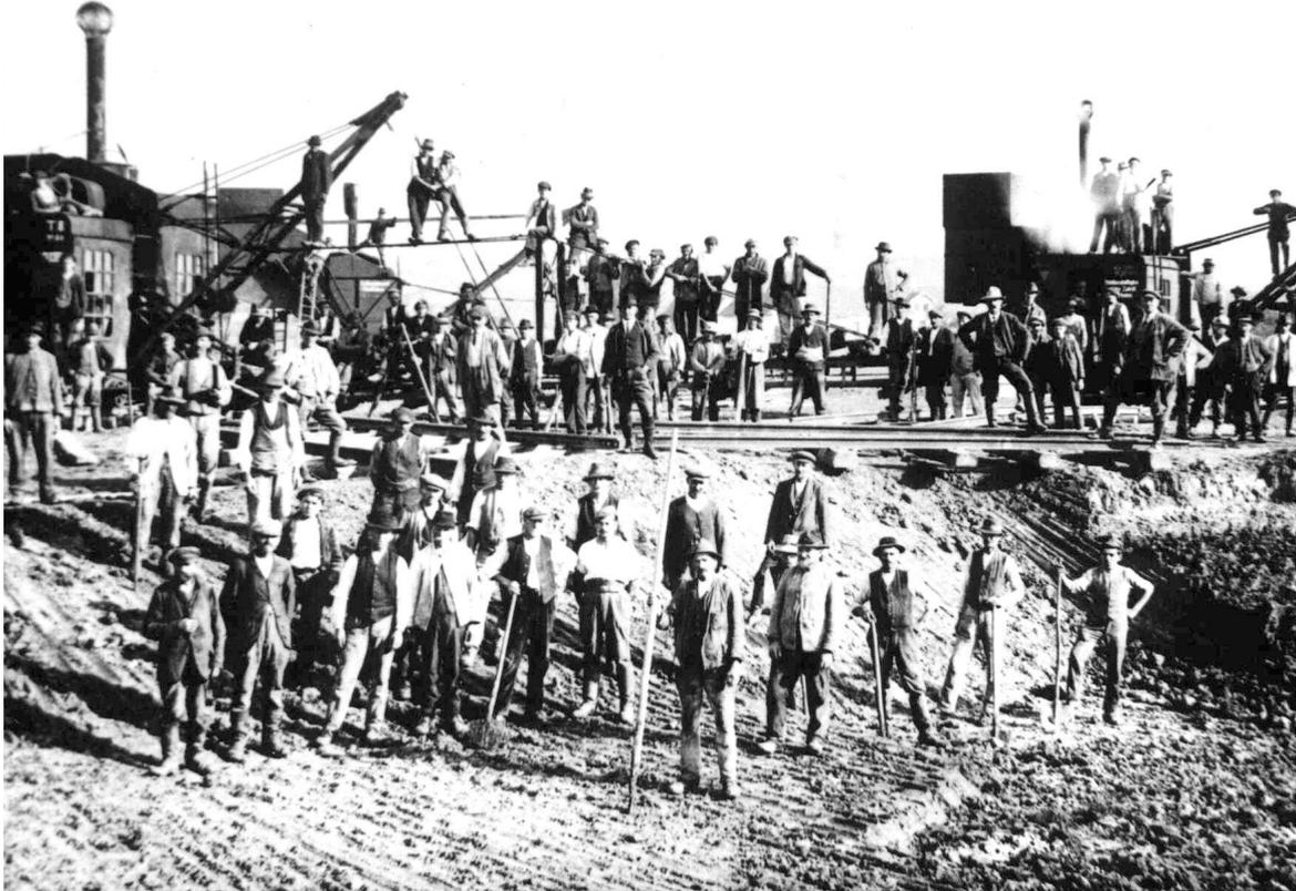
Dampfbagger und Arbeiter beim Bau des neuen Flussbettes
